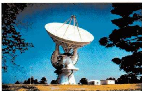
Figura TECPLA-27 Radiotelescopios como éste de Creen Bank, West Virginia, se utilizan para determinar con precisión la distancia entre dos puntos alejados. Los datos recogidos por mediciones repetidas han detectado movimientos relativos de las placas de 1 a 15 centímetros al año entre distintos puntos de todo el mundo (cortesía de National Radio Astronomy Observatory).
